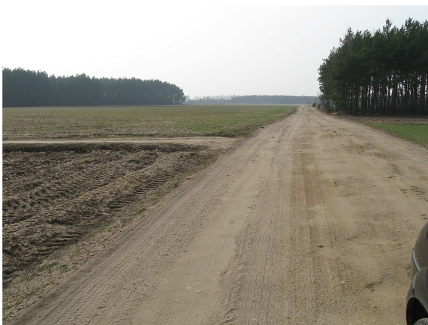
fot.2 Droga gminna w km 1 + 000,00
