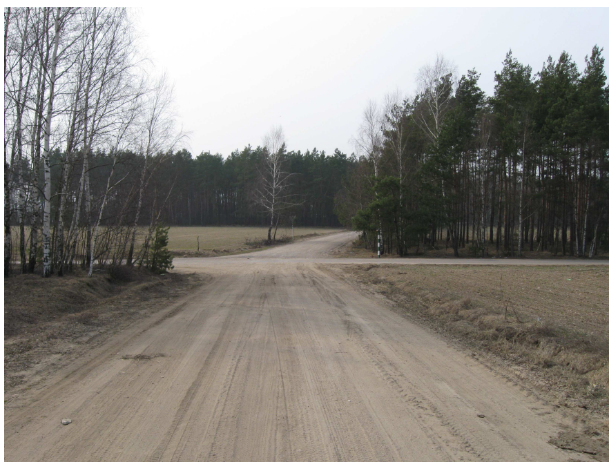
fot.1 droga gminna w km 0 + 000,00 (wlot do drogi powiatowej nr 3213W)
