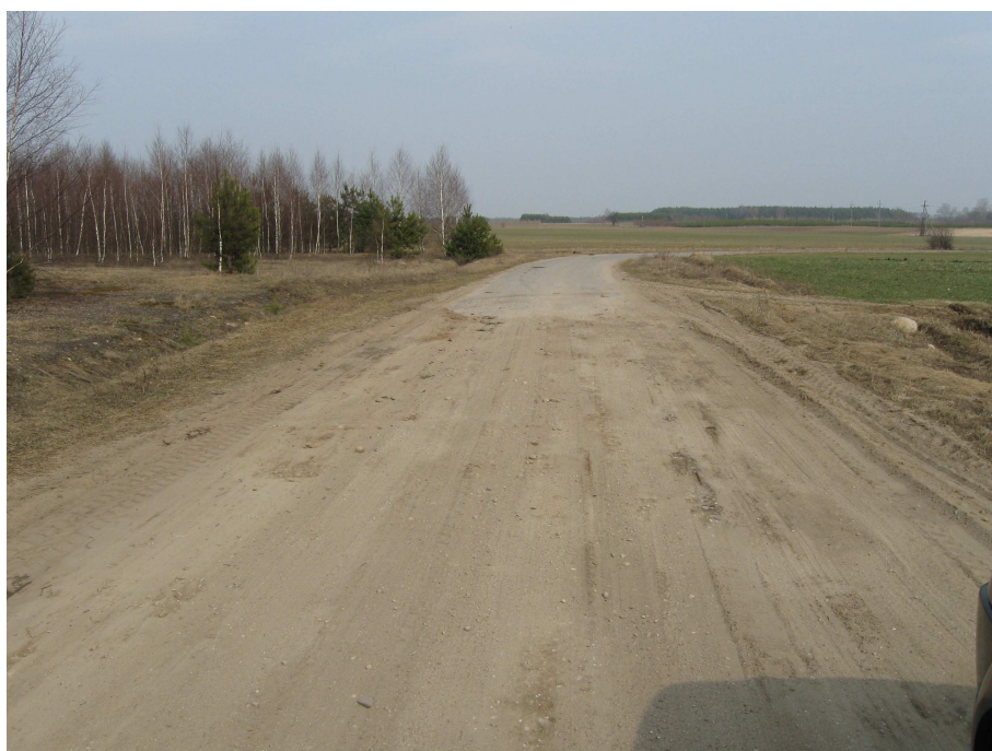
fot.3 droga gminna w km 2 + 088,50
