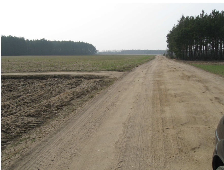
fot.2 Droga gminna w km 1 + 000,00
