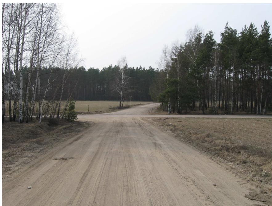
fot.1 droga gminna w km 0 + 000,00 (wlot do drogi powiatowej nr 3213W)
